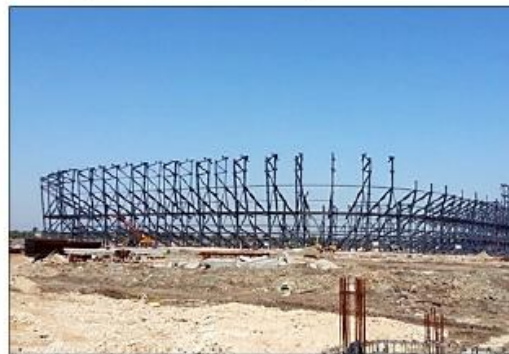
Estructuras metálicas de uno de los estadios de Irak. EE
